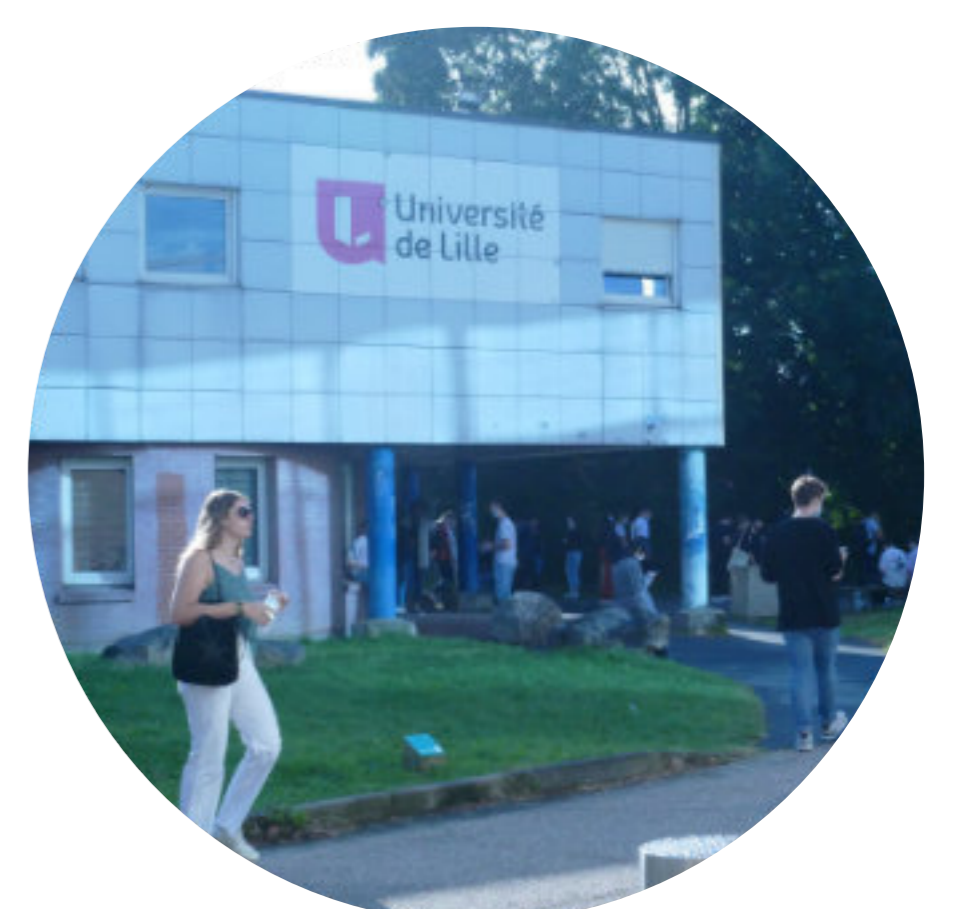
Le bâtiment SH1 visible depuis la sortie de métro
