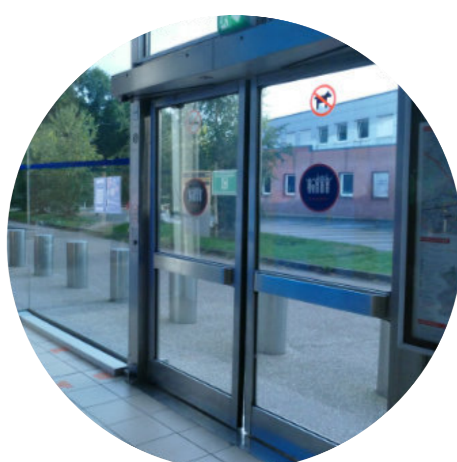
La porte vitrée B donnant vers les bâtiments de sciences humaines
